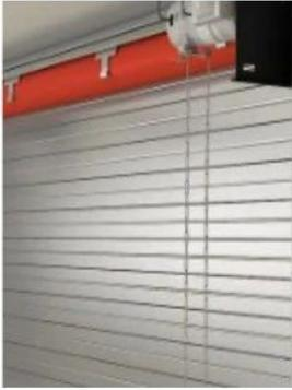
(1) 机械应急（手动）控制：即机械应急操作，拉动应急导链可使防火卷帘上升、下降。
