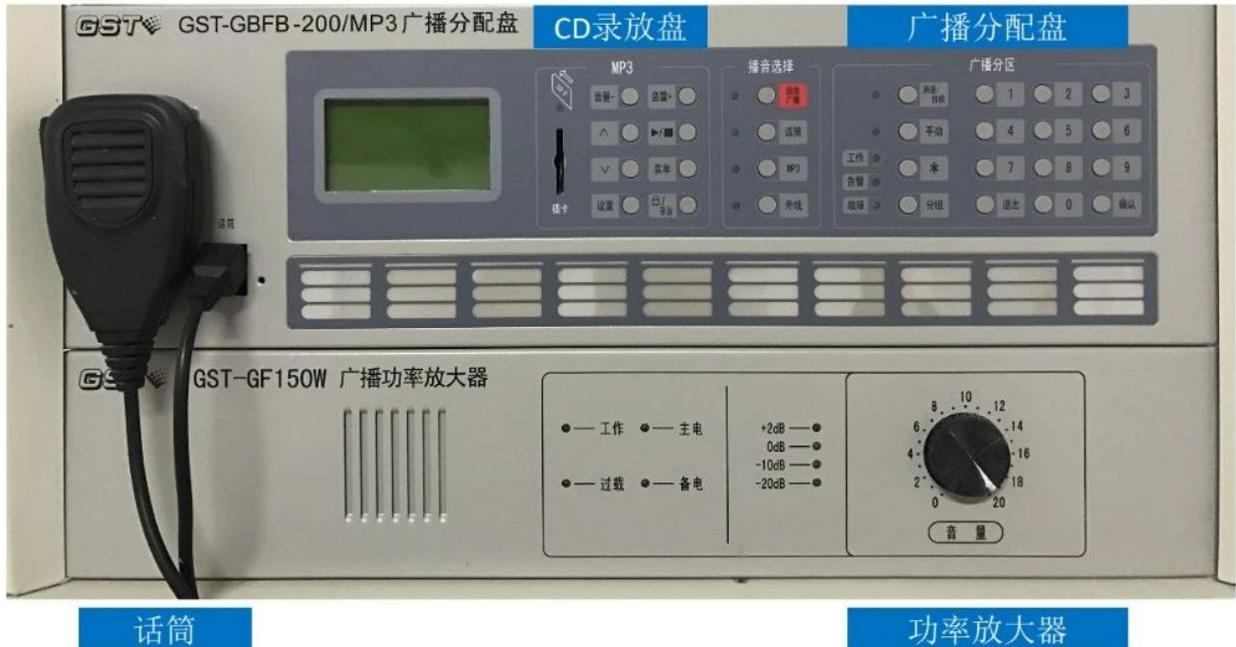
操作步骤：1、确保火灾报警控制器“**手动允许**”时，按下总线制控制盘上相对应的“广播”按钮，根据提示输入密码按确认，直至总线制控制盘上启动灯、反馈指示灯均点亮；2、拿起话筒，送话器正面朝向自己；3、将功放旋钮旋至最大；4、按下“**应急广播**”按钮（确保红色指示灯点亮）；
