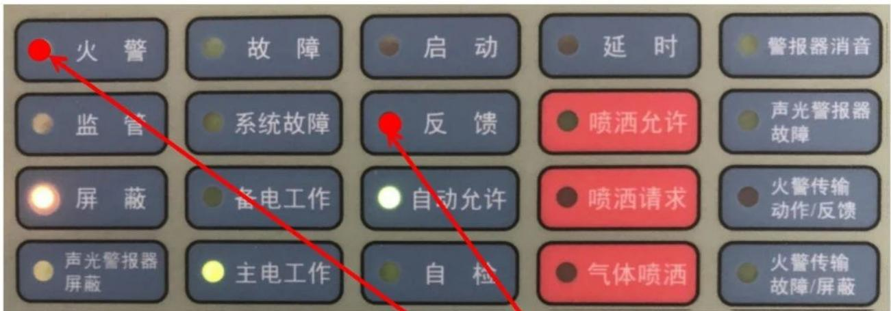
第一步：操作前一定看指示灯区，**火警灯**、**反馈灯**是否点亮，两者亮一个或同时亮都无法自检。在无火警、无反馈情况下按下 **1 自检**，如有密码提示请按下 **确认** 进入自检界面。
