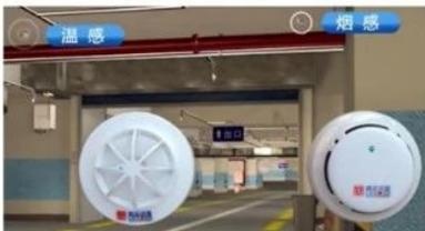
(4) 自动联动控制：根据设置的联动控制公式，感温、感烟探测器报警防火卷帘可进行联动自动控制下降。
