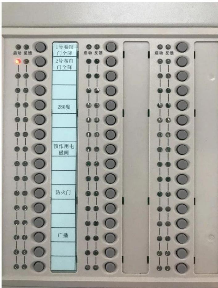
左图是总线制控制盘（又叫手动盘），使用手动盘首先要确认“启动方式”，确保启动方式为“手动允许”，在此情况下才可以控制相关联动设备，如果“手动禁止”，用
