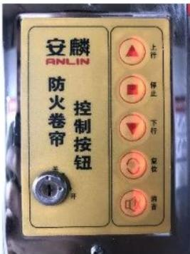
(2) 现场电动（使用电动控制器）控制：使用电动控制按钮开关可使防火卷帘上升、下降。
